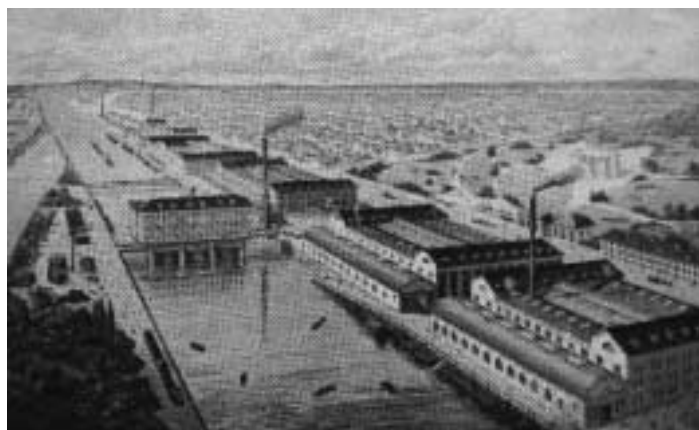
Εργοστάσιο Μενιέ. Οικοδομήθηκε απ' τον Ζ. Σολνιέ γύρω στο 1889. Συλλογή του Μουσείου Μενιέ
